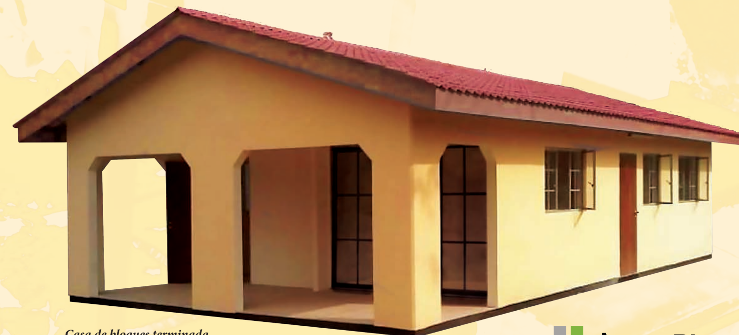
Casa de bloques terminada con revestimiento exterior
